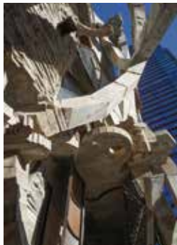
住宅部分の玄関あたり見上げ 様々な造形が積み上がっている。
